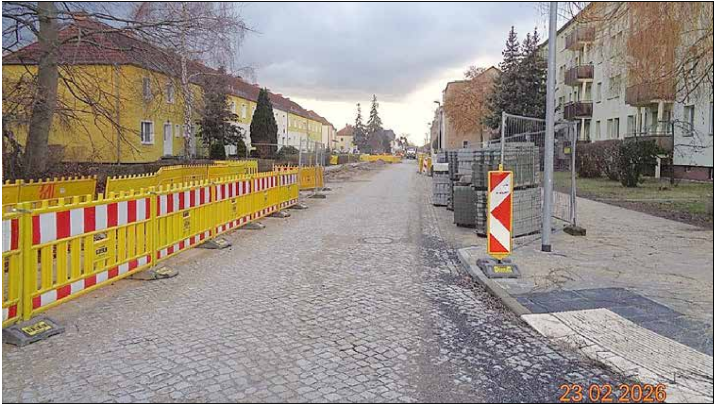
Blick in die Baustelle von der Straße des Aufbaus
