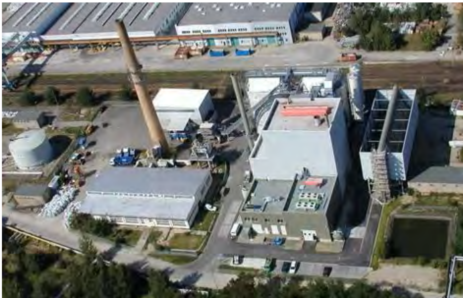
Abb. 16 - Luftbild Biomasseheizkraftwerk Stadtwerk Elsterwerda GmbH (Quelle: http://www.danpower-gruppe.de/se/unternehmen.html )
