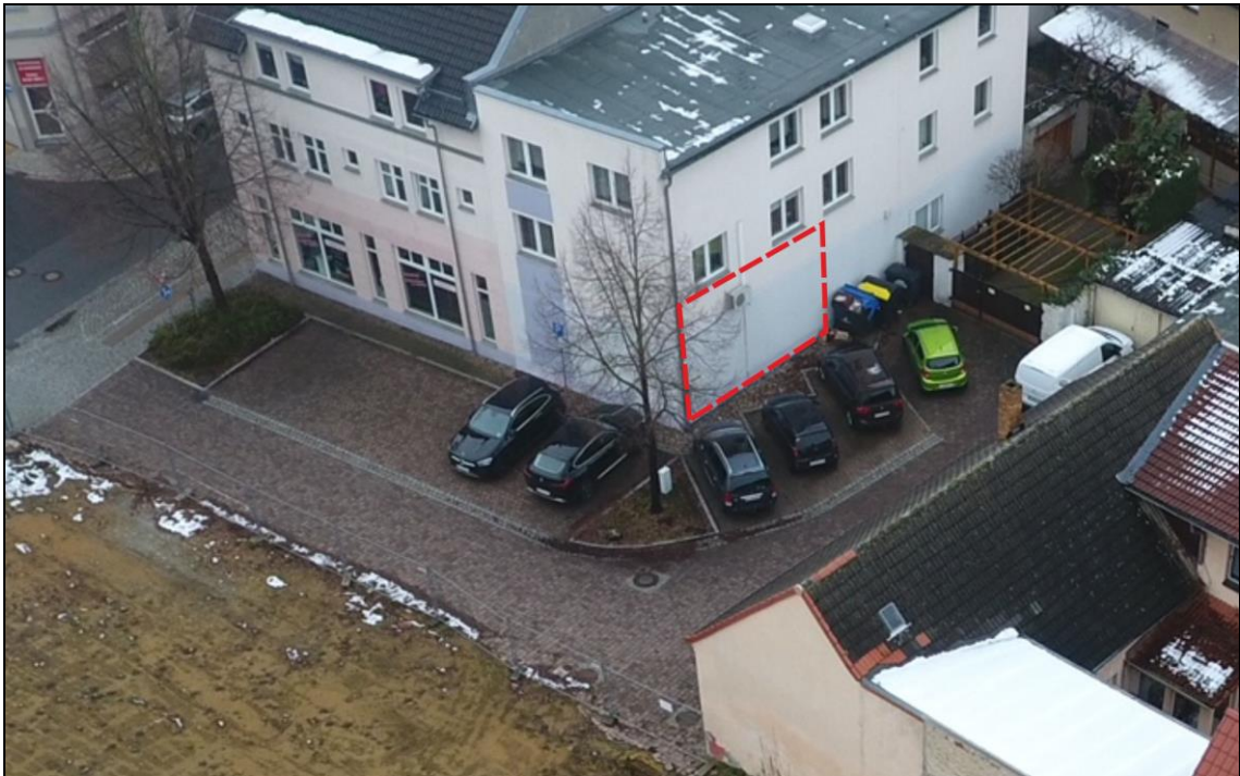
Abb. 14: Ostfassade des Anbaus von Haus Lange Straße 12a. Die fensterlose Fläche im Erdgeschoss, an der vorhabenbedingte Verschattungen berechnet werden, ist durch eine rote Rahmung hervorgehoben
