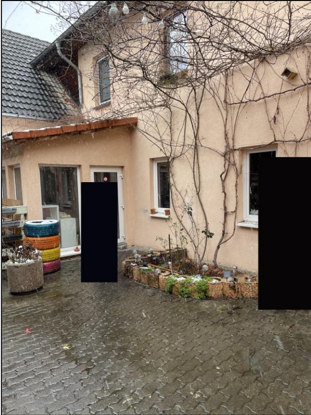
Aufnahme 4: bewachsene Südfassade Flst. 1013
