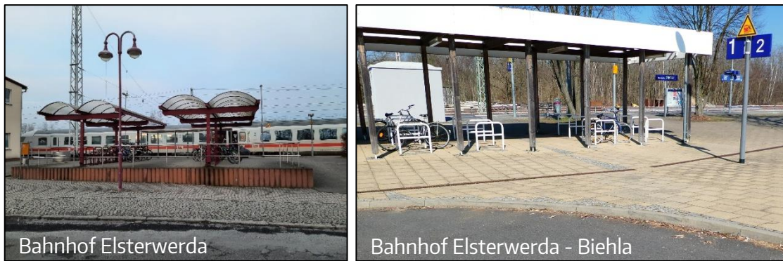
Abb. 13 Infrastruktur im Bestand - Radabstellmöglichkeiten Bahnhöfe
