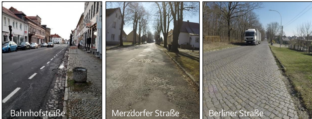
Abb. 10 Beispiele Oberflächendefizite
