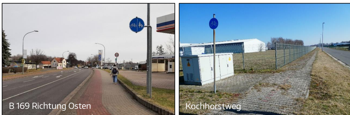
Abb. 3 Bestandsituation Geh- und Radweg B 169
