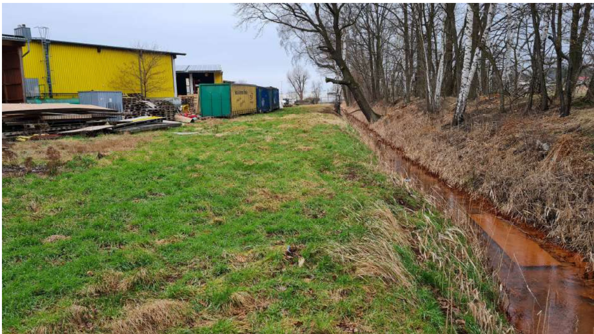
Abb. 1: Plessa-Haidauer Binnengraben mit angrenzendem Gehölzstreifen nördlich des Grabens (rechts im Bild) und zum Graben hin abfallenden Grünstreifen, der auch als Unterhaltungstrasse dient.
