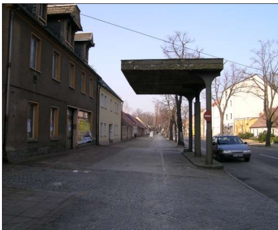
Berliner Straße (westlicher Abschnitt) vor...
