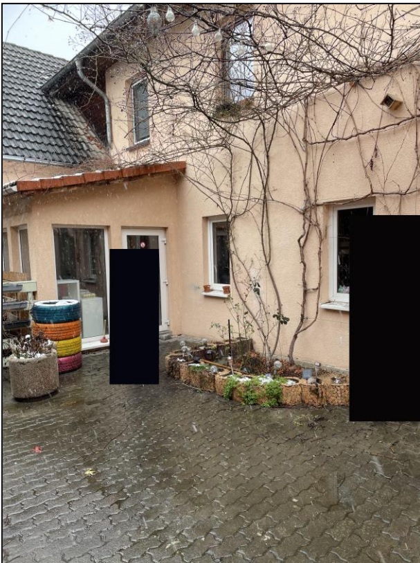
Aufnahme 4: bewachsene Südfassade Flst. 1013
