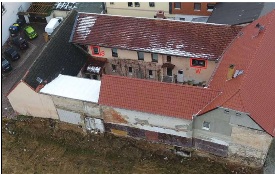
Abb. 15: Blick auf die Fenster der Südfassade im Innenhof der Gebäude Lange Straße 12c / Hauptstraße 25
